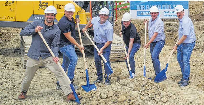
Spatenstich in Oeschgen am 5. Juli 2024.
